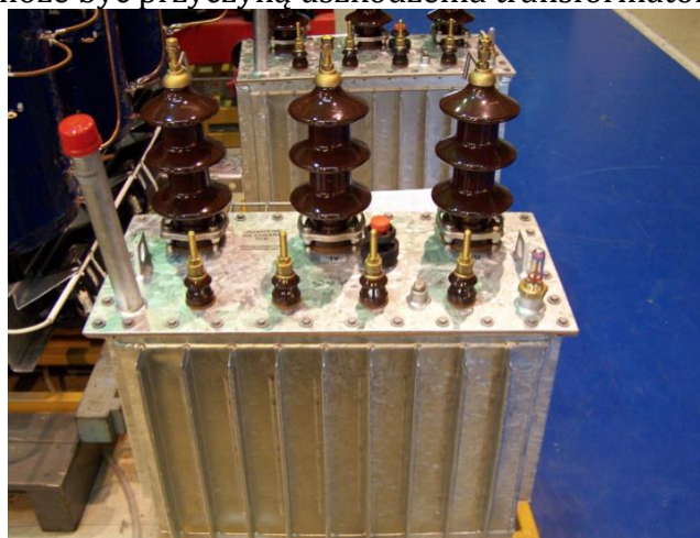
Rys. 6. Izolatory przepustowe typu DIN 42531
